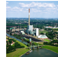
Walsum 600 MW 750 MW COD 2010
