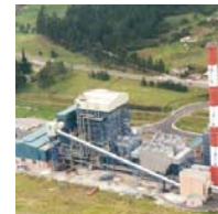
Termopaipa, Columbia 165 MW
